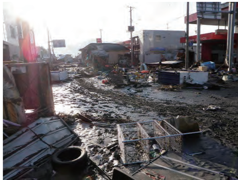
東日本大震災津波直後の国道106号 宮古市役所付近
